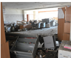
▲避難所となった石巻市の小学校
