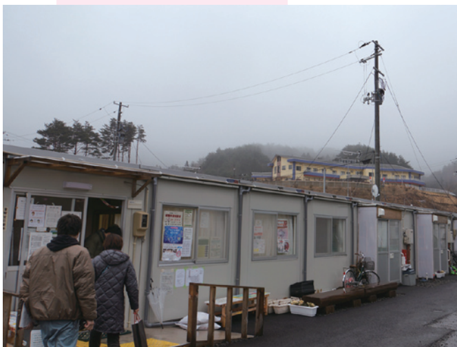
▲仮設住宅の様子(大槌町吉里吉里中学校)
