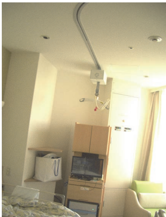
図2 病室内だけでなく、トイレや風呂場にも天井走行リフトが完備
